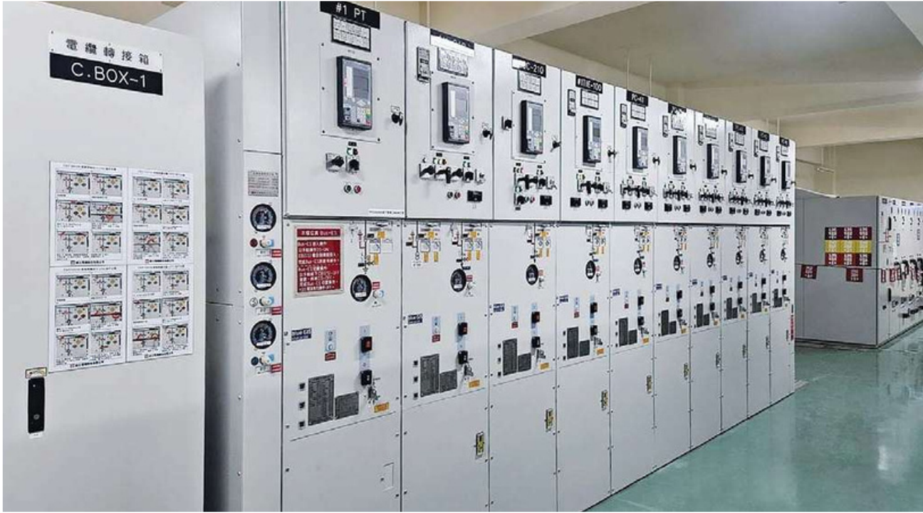
台電輸變電工程處北區施工處於玉里配電變電所 23 kV 環保型氣體絕緣開關組立完成照。
