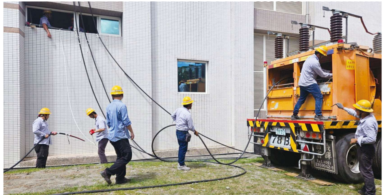
台電輸變電工程處北區施工處同仁延放試驗電纜。
